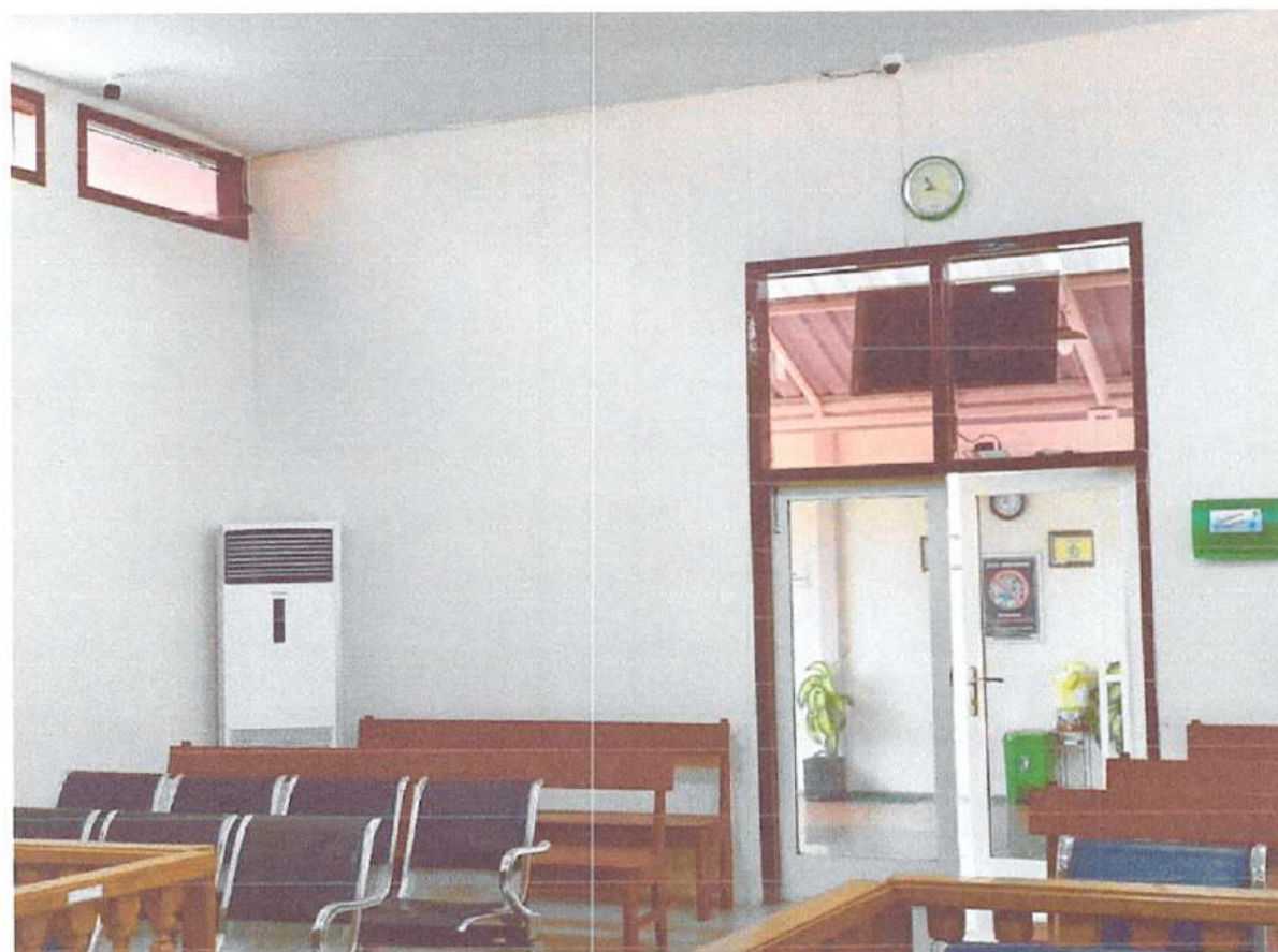
Pemasangan CCTV pada Ruang Sidang Pengadilan Negeri Situbondo
